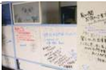
茜色に染まる解体前の万代小学校。現在解体中。上は参加者がそれぞれの慕いを落書きで廊下の壁に一言一言。右は校庭内プレハブに保管されていた校歌の額
