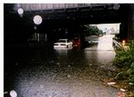
JR交差点の冠水状況 (H10.8.4)
